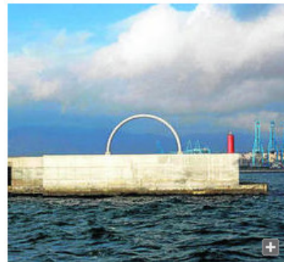
El dique exento de Isla Verde Exterior y uno de los arcos que lo señalizan.
